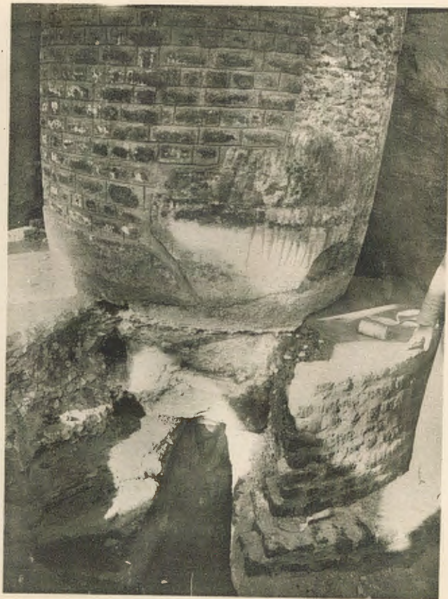
Fondation d'une des colonnes de la rangée nord de la Grande Cour.
